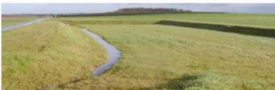
Une digue de terre est un aménagement hydraulique qui consiste à barrer un fond de vallon, afin de réguler les débits de ruissellement en stockant temporairement un grand volume d'eau. Pour cela, la digue est pourvue d'une conduite d'évacuation ou ouvrage de fuite. Elle comporte aussi une surverse (déversoir de crue) qui assure, si nécessaire, le débordement de l'ouvrage de façon contrôlée.
