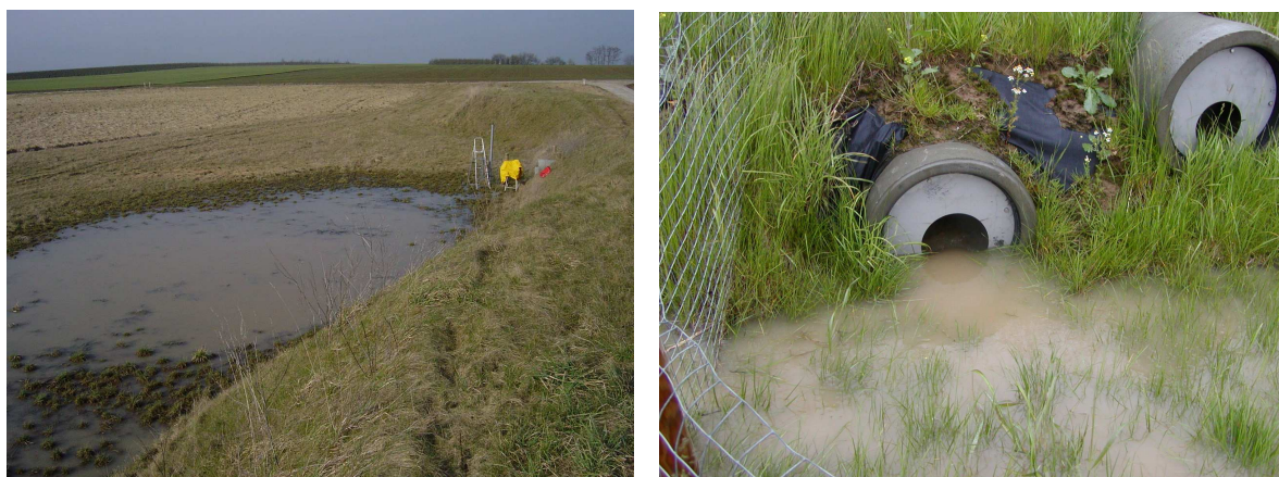
Figure 10. Digue en terre installée dans un bassin versant pilote à Velm
