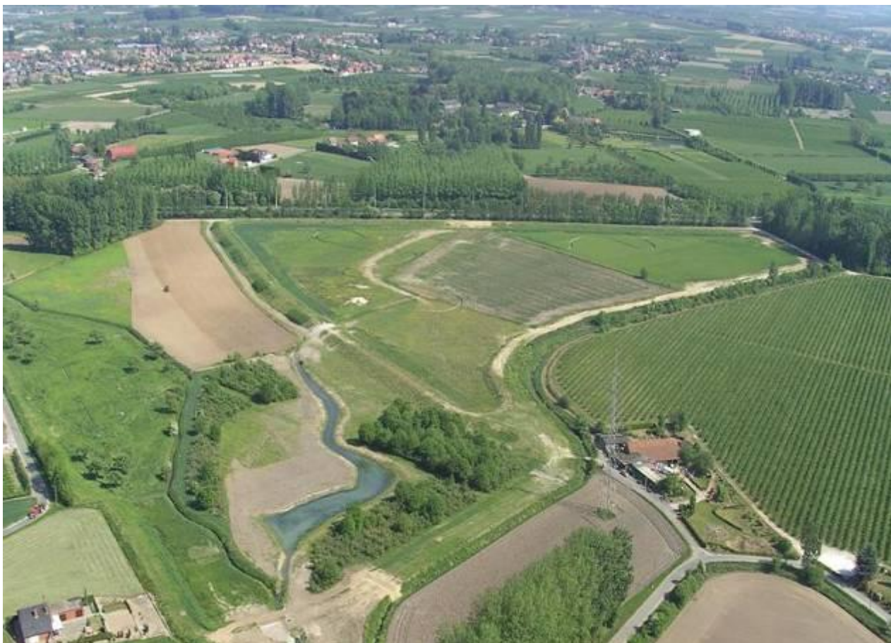
Figuur 26: foto na de werken (zicht op zone 1 en zone 2) (Watering van Sint-Truiden)
