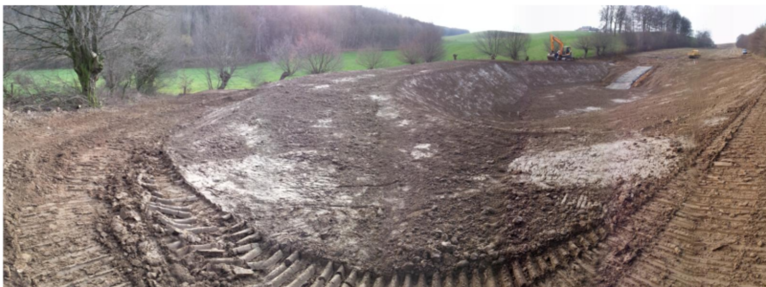
Foto : zicht op perceel tijdens de aanleg van damconstructie en erosiepoel
