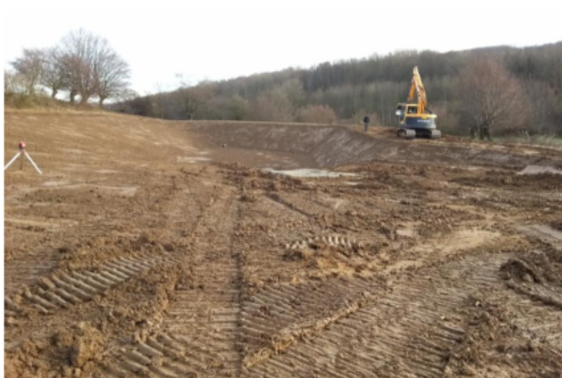
Foto : zicht op erosiepoel en damconstructie tijdens de werken
