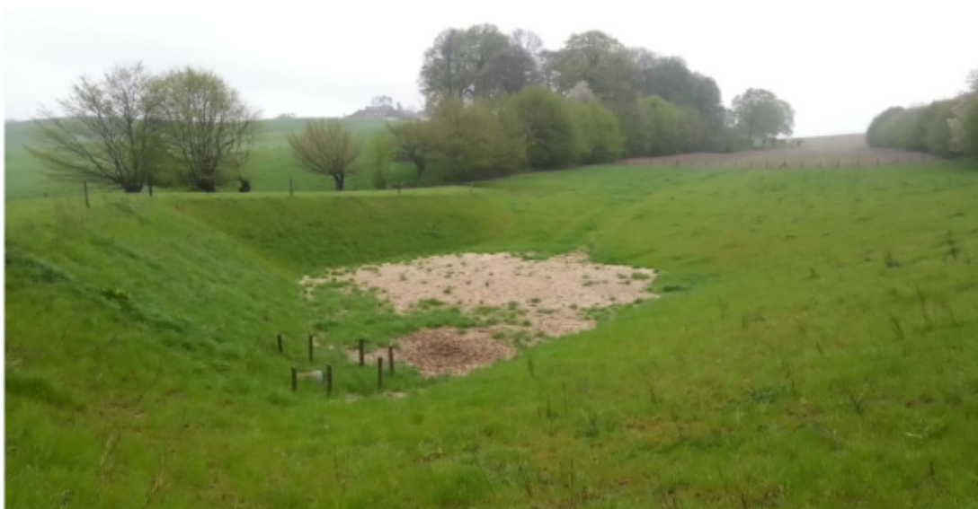
Foto : zicht op damconstructie en erosiepoel, 1 jaar na aanleg
