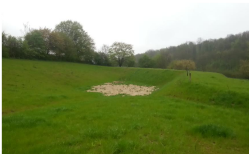
Foto : zicht op erosiepoel en damconstructie, 1 jaar na de werken
