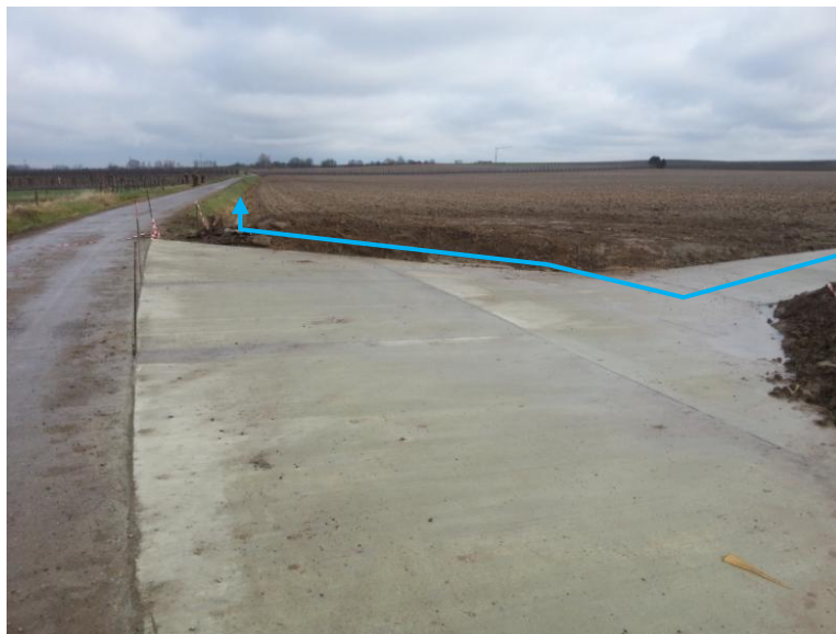
Foto 10: zicht op wegverlaging na de werken
