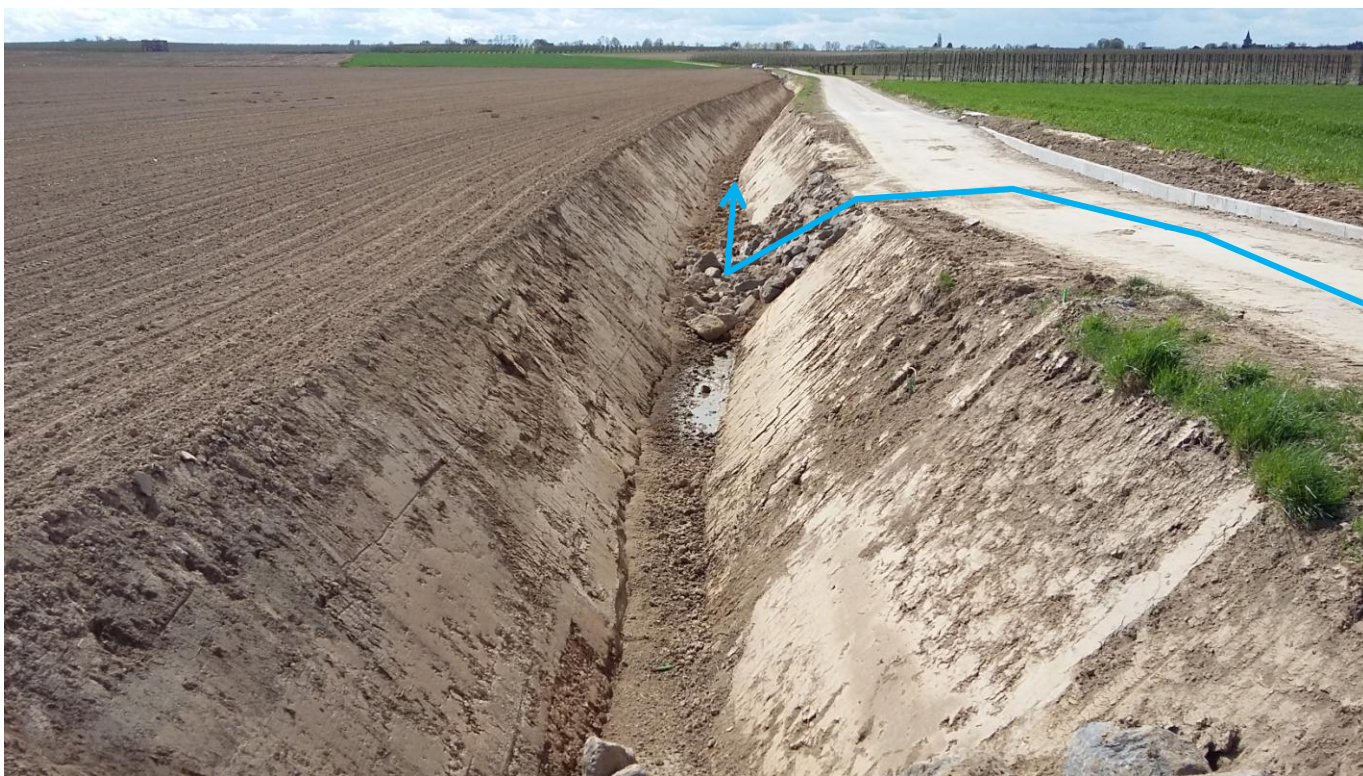
Foto 9 : zicht op wegverlaging na de werken
