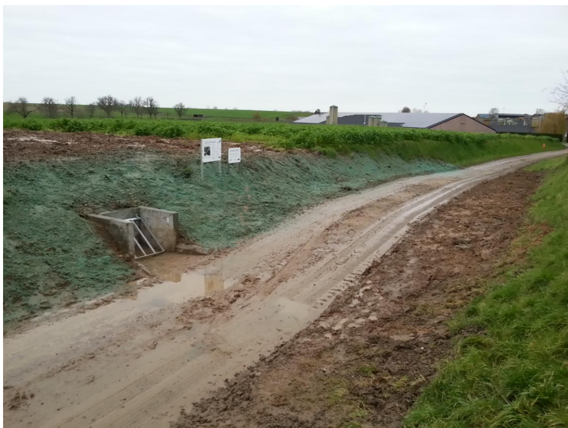
Foto 7 : toestand na de werken, zicht op bufferende wegdrempel en afvoerbuys naar wachtbekken
