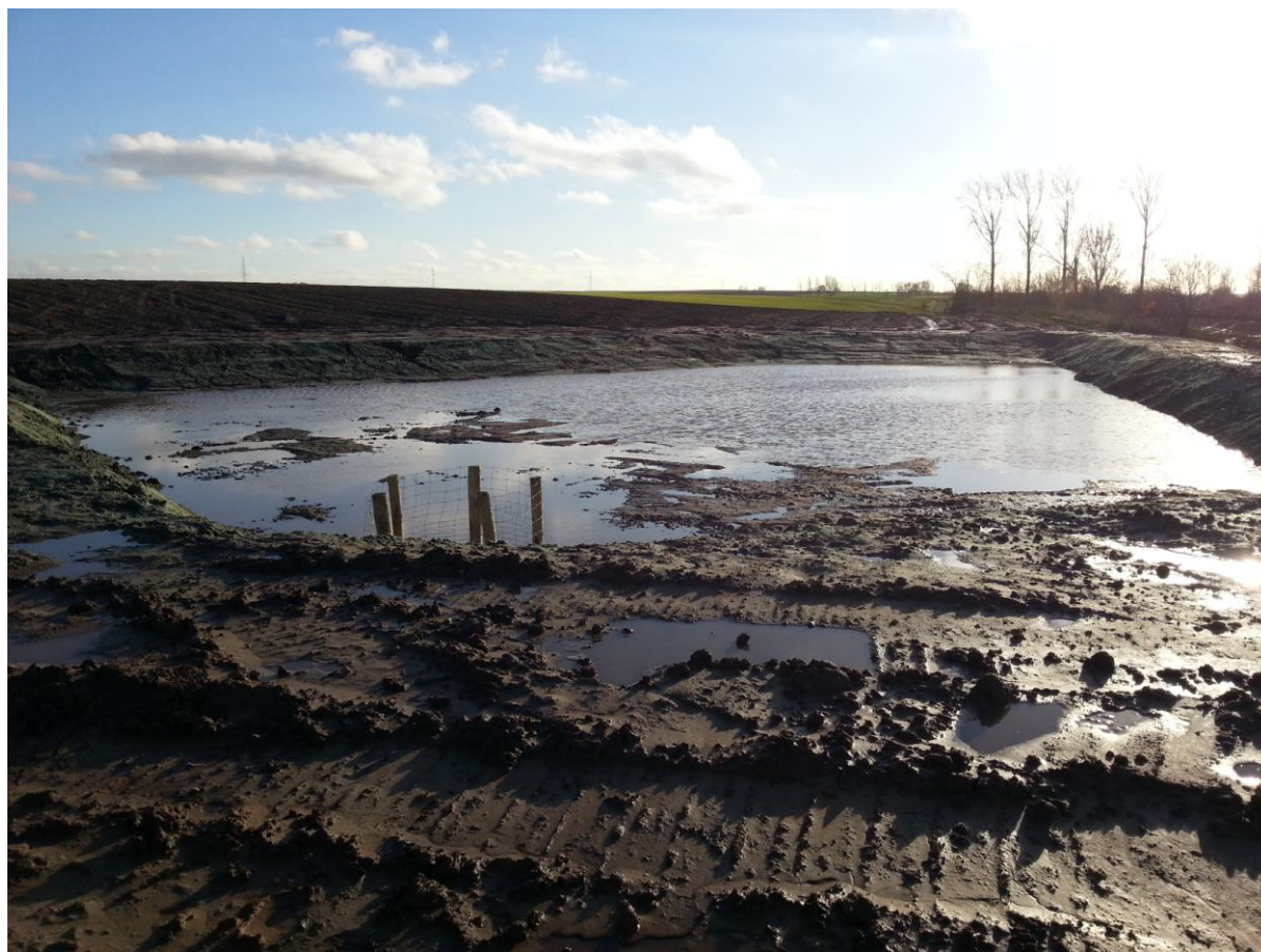
Foto 5 : toestand na de werken, zicht op erosiepoel en erosiegevoelig akkerperceel
