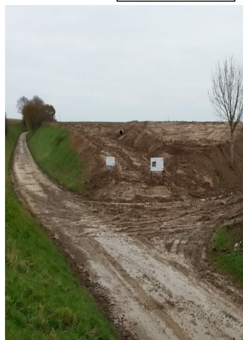
Foto 3 : toestand na de werken (aarden dam)
