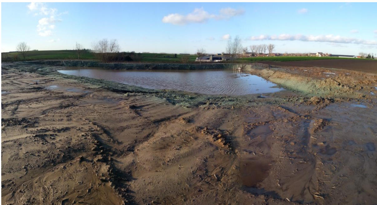
Foto 4 : toestand na de werken, zicht op erosiepoel en aarden damconstructie
