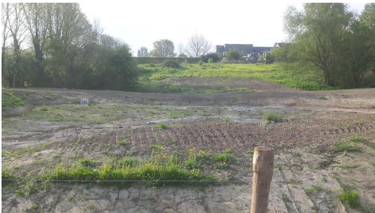
Foto 8 : locatie bufferbekken net na de werken
