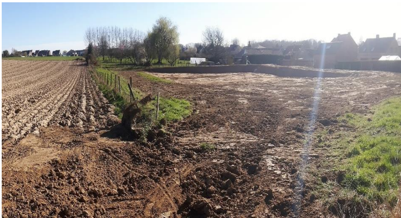
Foto 2: Toestand na de werken, zicht op erosiepoel (voorgond) en erosiedam (achtergrond)
