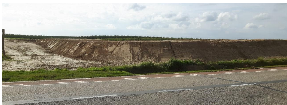
Foto 8: toestand na de oorspronkelijke erosiewerken
