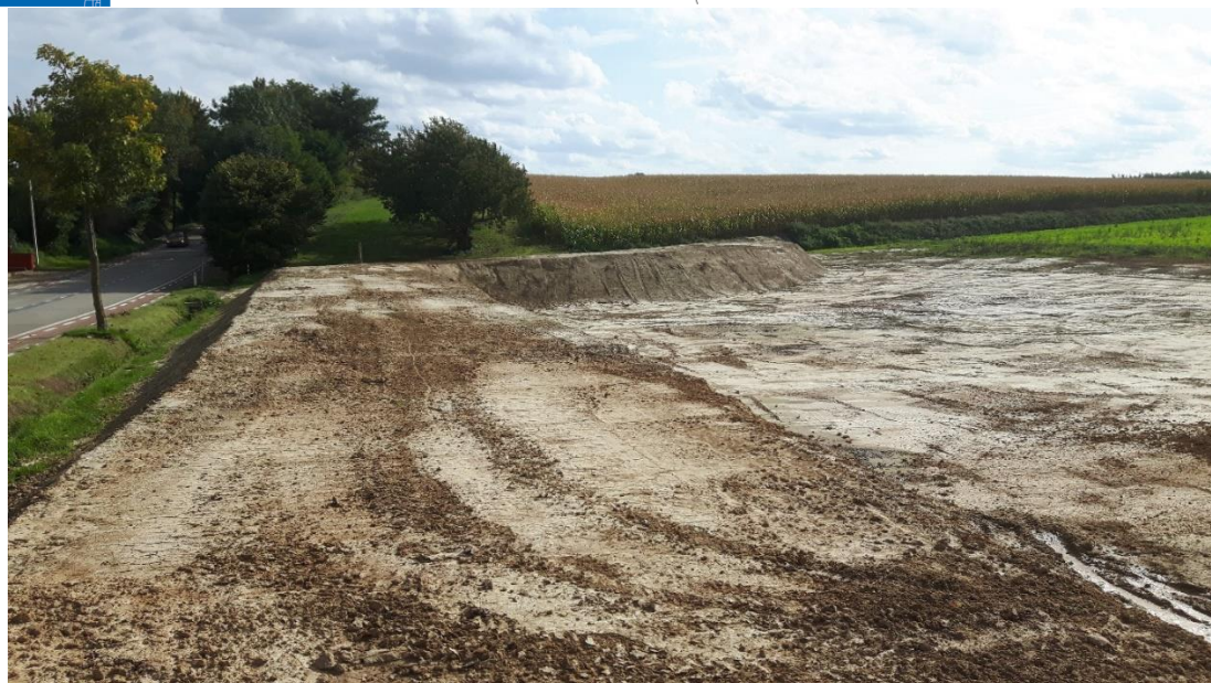
Foto 5: zicht op oorspronkelijk erosiedam vóór de uitbreidingswerken
