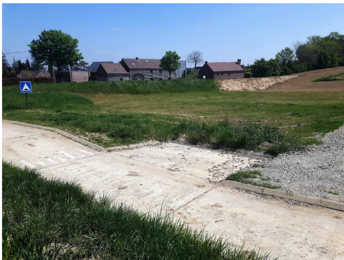
Foto 2 : Na de werken, een deel van de erosiedam werd afgebroken én verlegd.
