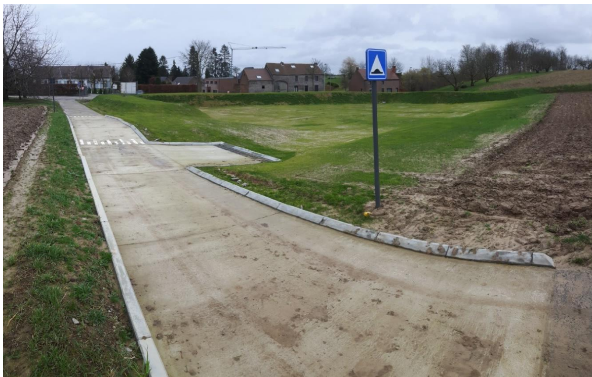
Foto 1 : zicht op bufferzone en erosiedam vóór de uitbreidingswerken
