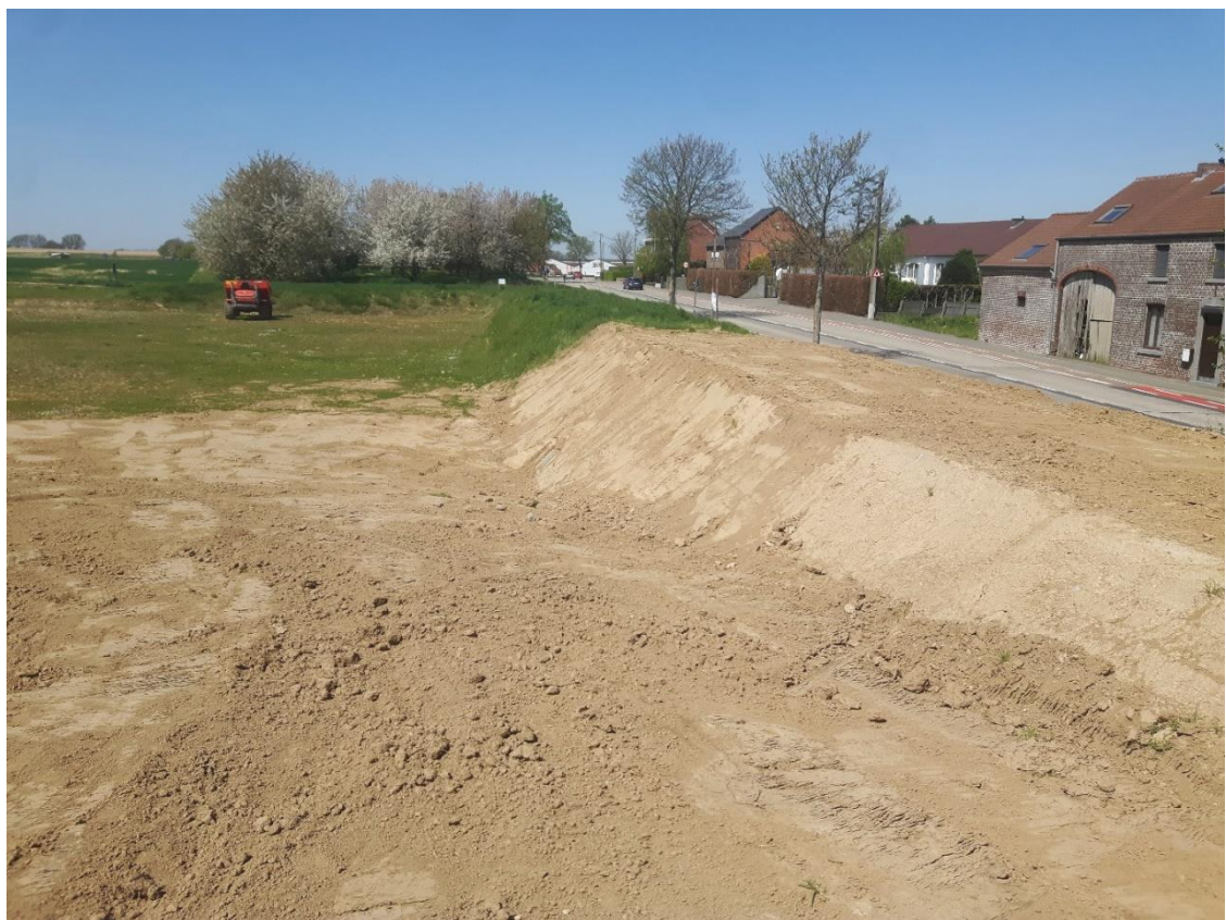
Foto 4 : Toestand na afbraak én verlegging deel erosiedam
