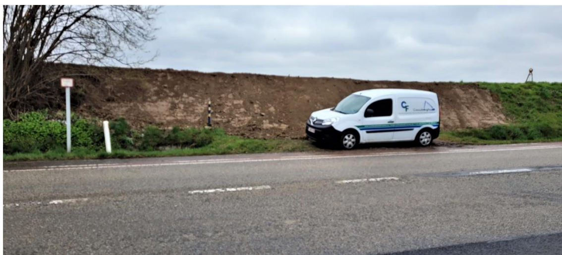
Foto 9 : toestand na de uitbreidingswerken
